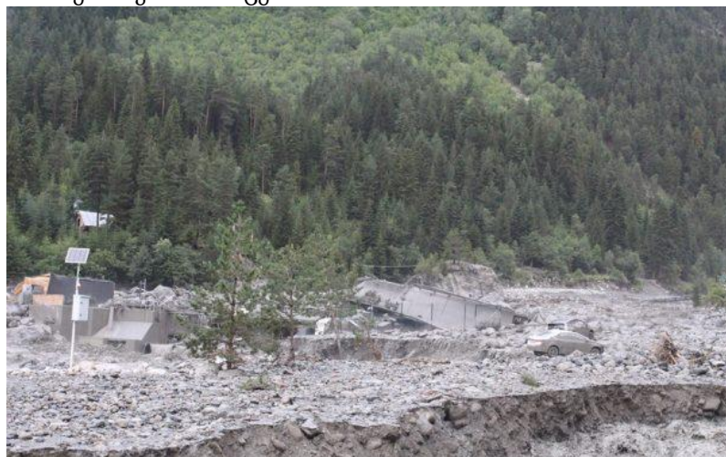
ნახ. 3. მდ. მესტიაჭალაზე მომხდარი წყალმოვარდნა, ფოტოზე მოცემულია ჰესის მშენებლობის ტერიტორია
