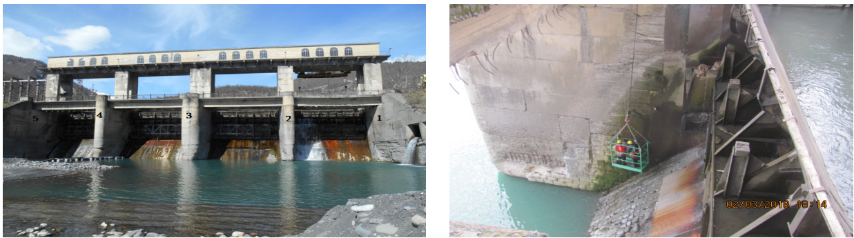
ნახ. 1. ა) ცაგერის წყალშემკრები. 1 – აღმოსავლეთი კედელი, 2 – პირველი (აღმოსავლეთი) ბურჯი, 3 – მეორე (ცენტრალური) ბურჯი, 4 – მესამე (დასავლეთი) ბურჯი და 5 – დასავლეთი კედელი. ბ) ულტრაბგერითი სამუშაოების ამსახველი სურათი წყალშემკრები აუზის კაშხლის მზიდ ბურჯებზე და კედლებზე.
