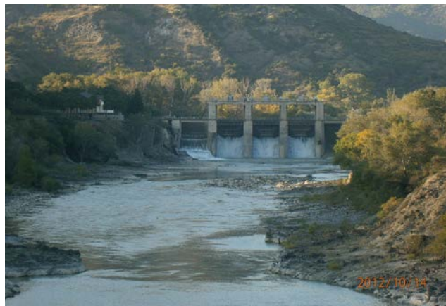
Земо Авчальская ГЭС
