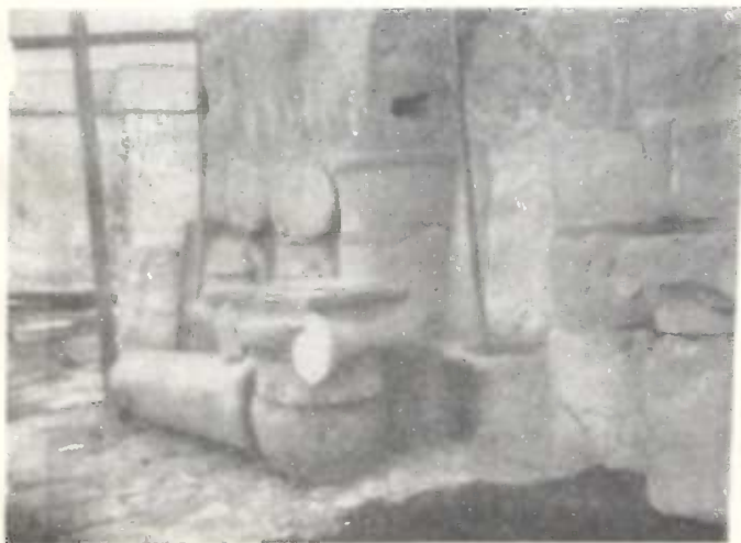
2. Терраса въ домѣ русской Миссіи въ Тиверіадѣ. Остатки колоннъ и капителей, частью встроеныя въ стѣну.
