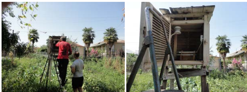
ნახ. 1 სარეჟიმო აპარატურის მონტაჟი ლაგოდეხის მეტეოსადგურზე
