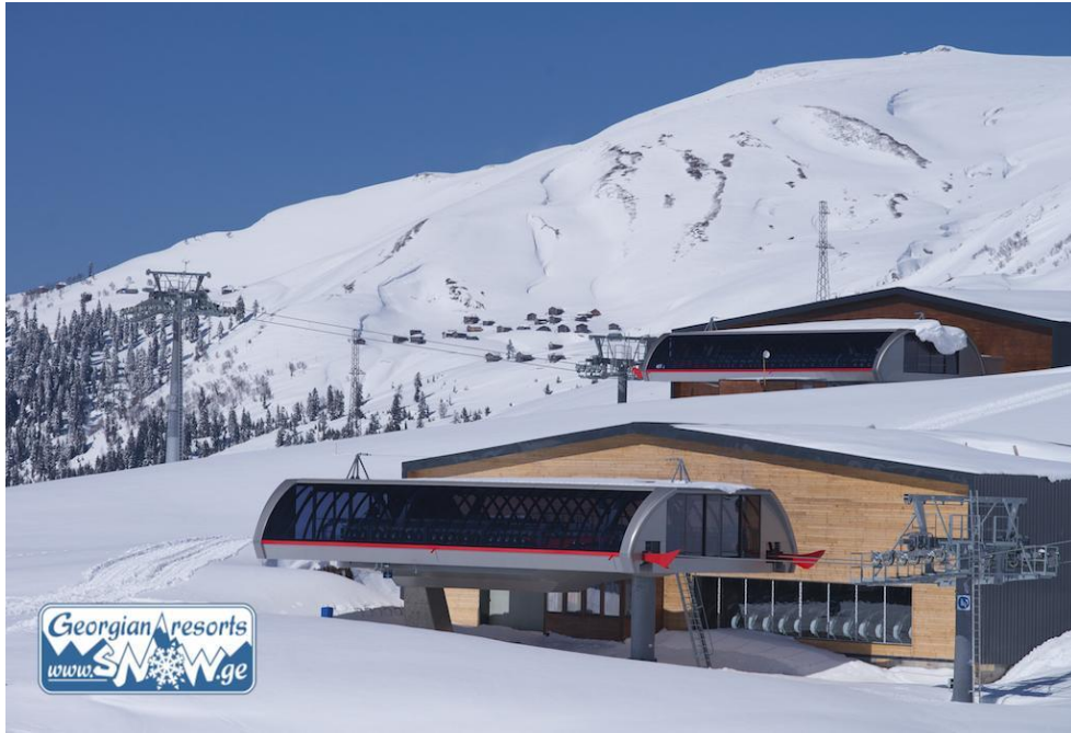
ნახ.7.6 საბაგრო გზა კურორტ „გოდერძი“-ზე (2025 მ)
