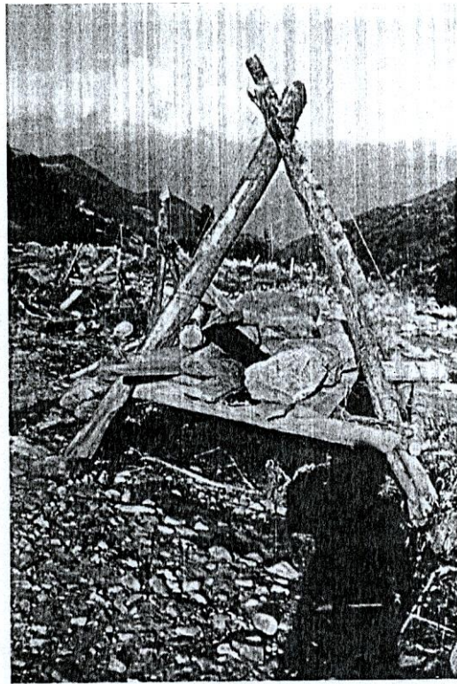
მდ. ხელედულაზე 1983 წ. 19-20 ივლისში გავლილი ღვარცოფებისაგან დასაცავად აგებული დროებითი ნაპირდამცავი ნაგებობები.
