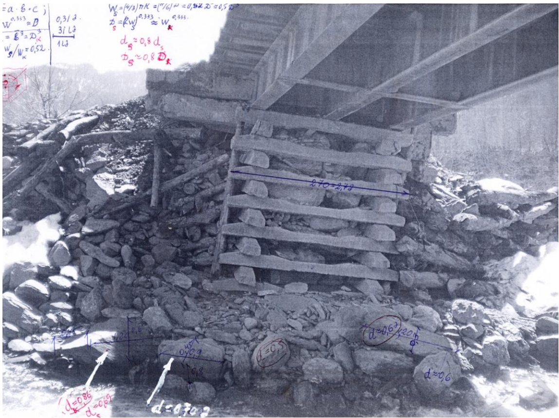
ნახ. 14 მდ. მურგოულზე ღვარცოვით დაზიანებული ხიდის ფრაგმენტი. 2009.
