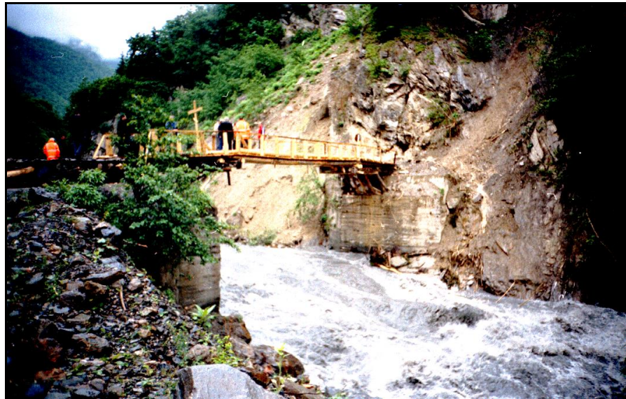
ნახ. 11 საავტომობილო გზა ლენტეხი – სასაშის მონაკვეთზე მდ. ცხენისწყლის მიერ წაღეკილი ხიდის ადგილზე აშენებული ერთი მსუბუქი მანქანის გამტარობის მქონე დროებითი ხიდი.
